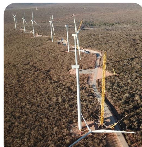
Montagem dos aerogeradores
