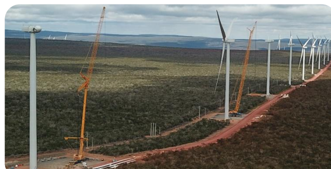
Montagem dos aerogeradores
